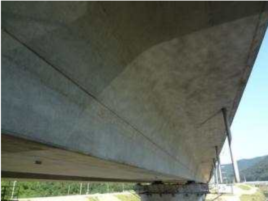
거더 외부 전경
