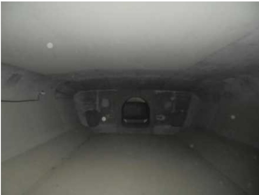
거더 내부 전경
